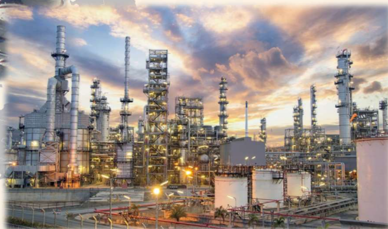
プラント工場
